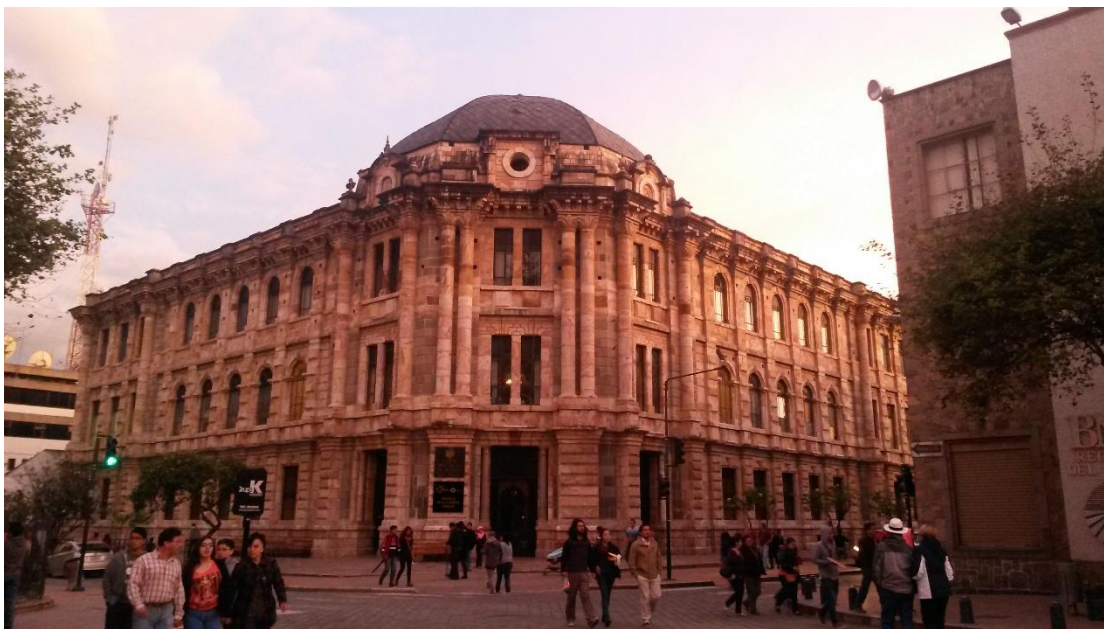
Edificio de la Corte Provincial de Justicia de Azuay, calle Mariscal Sucre.
