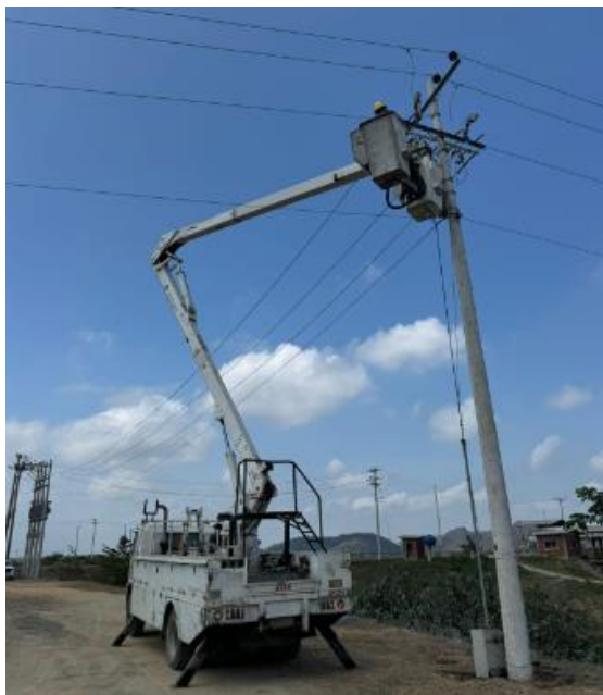
Figura 21. Instalación de transformadores para una correcta tensión de corriente a los tableros de distribución. Fuente propia.
