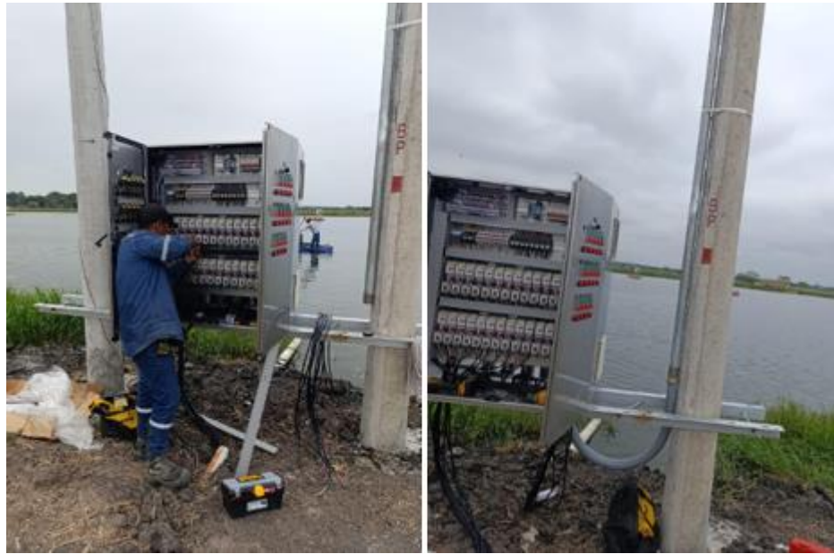
Figura 19. Ajuste de conexiones, cambio de contactores y guardamotores en tableros de control de aireación eléctrica. Fuente propia.
