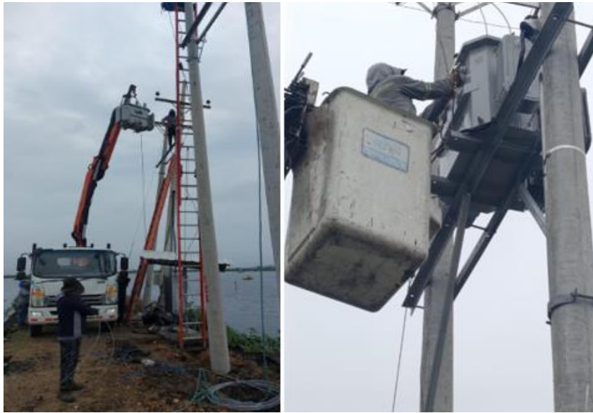
Figura 21. Instalación de transformadores para una correcta tensión de corriente a los tableros de distribución. Fuente propia.
