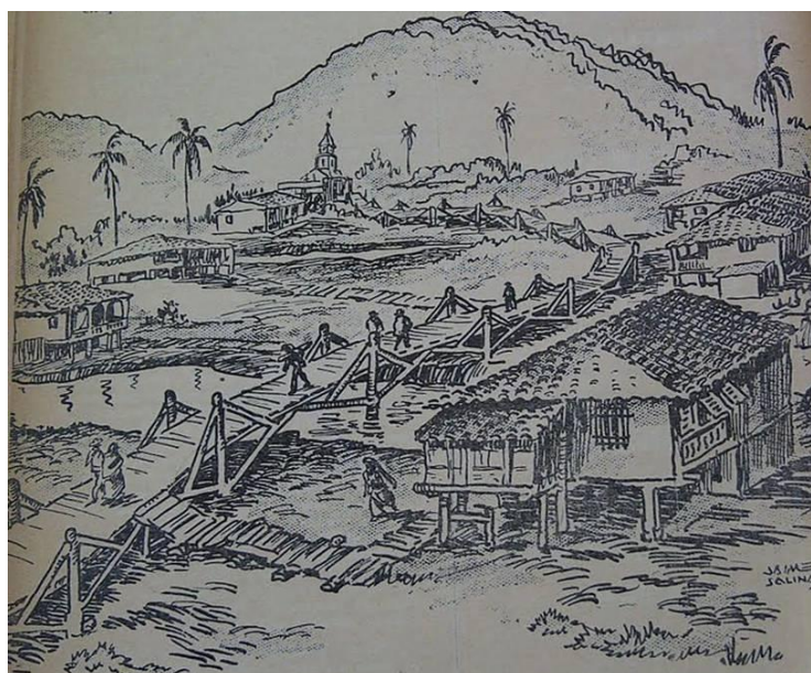
Figura 1 Puente que conformaba la calle Panamá
