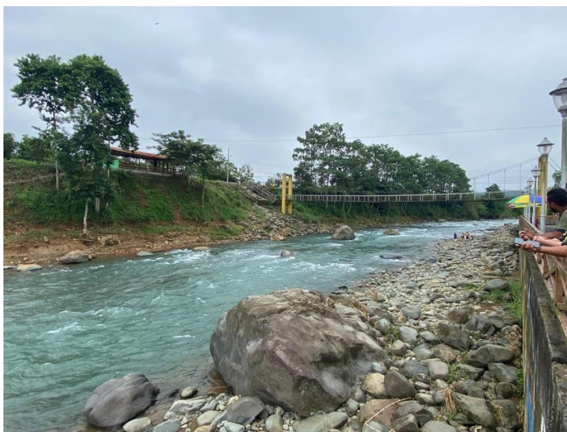
Figura 4: Vista del Malecón y Puente Colgante
